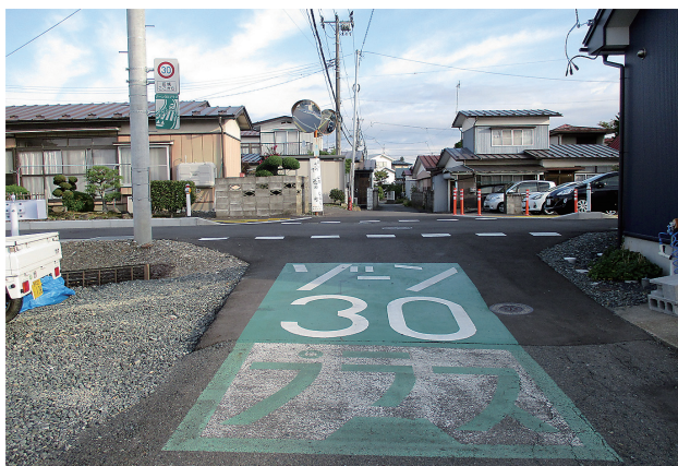
ゾーン30の道路表示(四日町二丁目付近)
